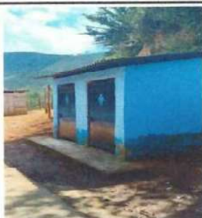
Foto 3: Mejoramiento de paredes y estructura metálica en modulo de sanitarios, asi mismo puertas de metal.
