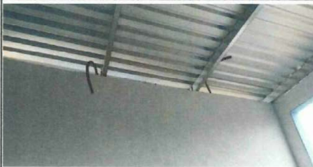
Foto 9: Mejoramiento de sistema eléctrico principal y sus accesorios (en aulas).
