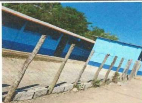
Foto 1: Mejoramiento de mala metálica por block.
