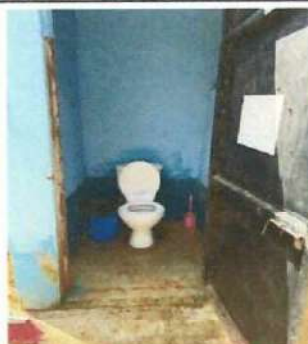
Foto 4: Sustitución de sanitarios en mal estado.
